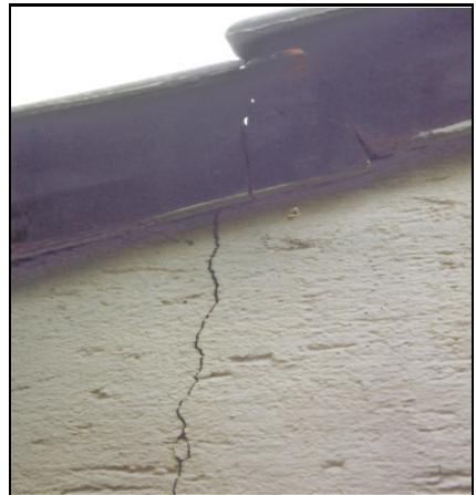
*Auf dem Bild geht der Mauerriss ohne direkte kraftschlüssige Verbindung in die*
